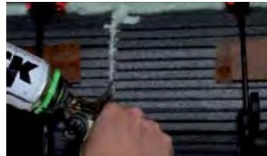
**Dämmplatten in allen Stoßbereichen sowie zum Mauerwerk mittels Montageschaum fixieren und abdichten**
