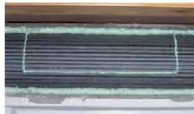
**Zu Revisionszwecken: Dämmung links + rechts sowie unten einschneiden und Dämmung aufklappen. Nach Revision, Schnitte wieder verkleben und abdichten**
